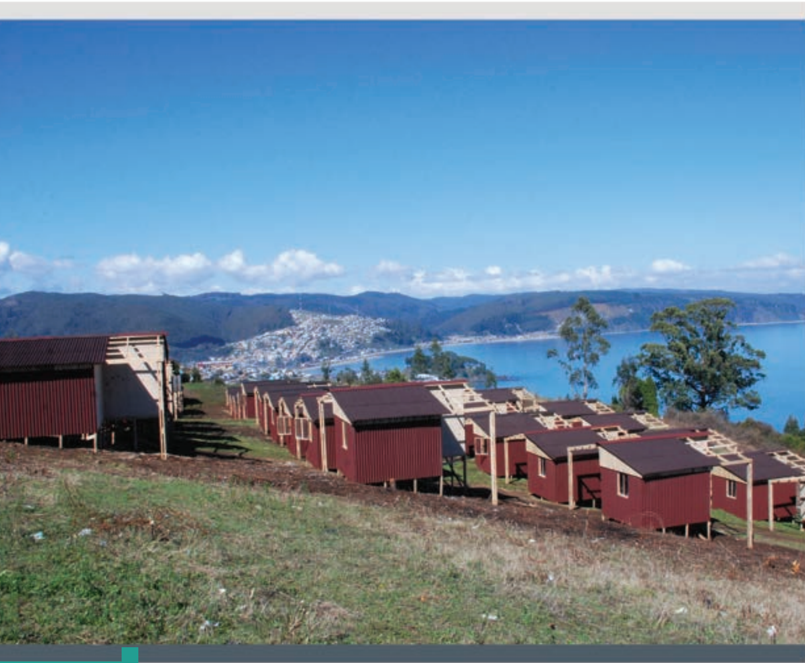
AVINA participó activamente en la construcción de viviendas de emergencia después del terremoto y tsunami de Chile
